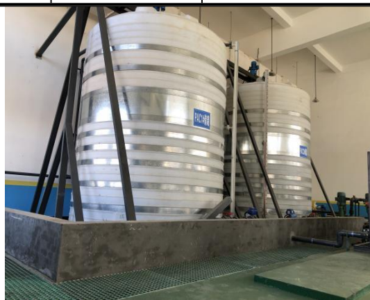
项目一期储罐围堰
