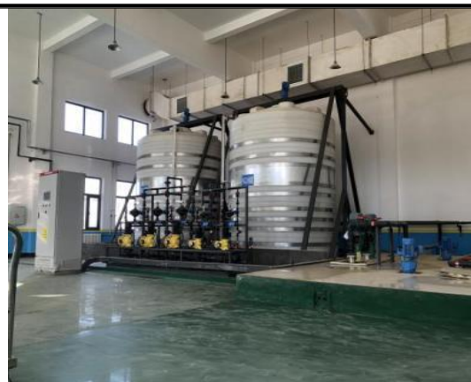
项目一期加药间地面
