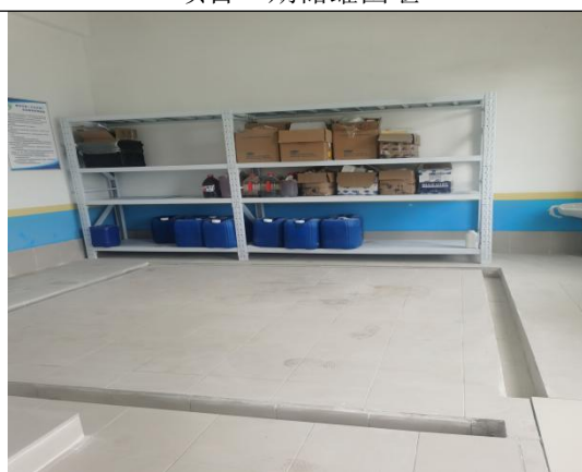
项目一期危废暂存间地面
