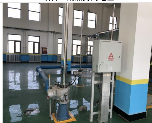
项目一期格栅间地面
