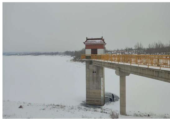
现有放水建筑物
