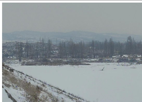
石崩水库西侧
