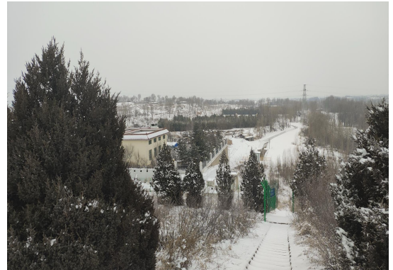
麻黄梁工业园区供水泵房
